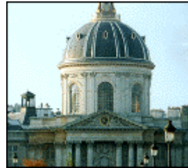
Vue actuelle de la chapelle du Palais de l'Institut
